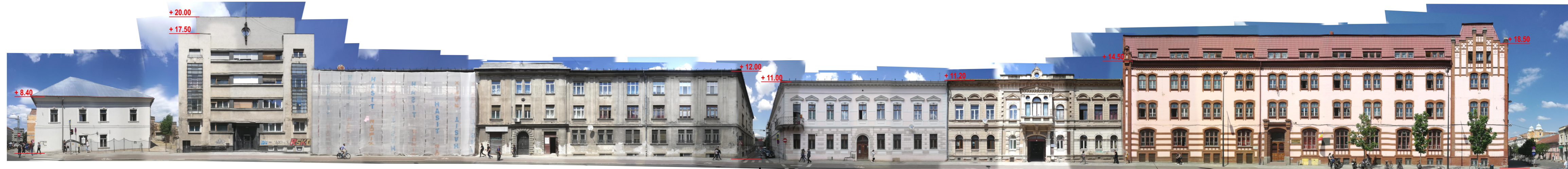
str. Avram Iancu nr. 1 str. Avram Iancu nr. 3 str. Avram Iancu nr. 5 str. Avram Iancu nr. 7 spre str. Fortaretei str. Avram Iancu nr. 9 str. Avram Iancu nr. 11 str. Avram Iancu nr. 13
