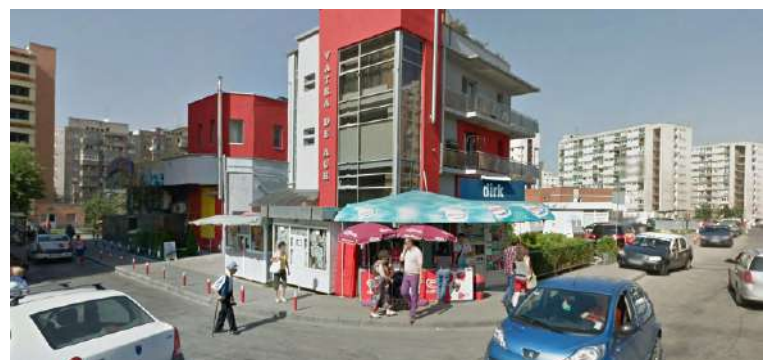
Spații comerciale amplasate în construcții parazitare
