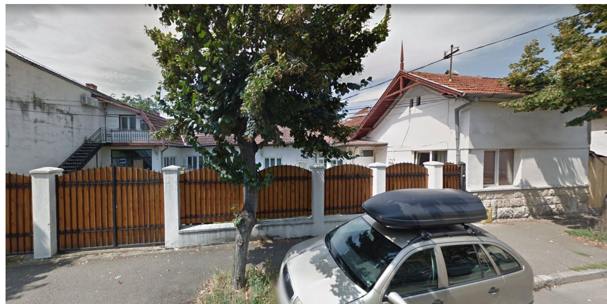
VEDERE DIN STRADA DE PE LATURA ESTICA
