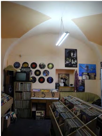
25. Încăperea P04 – boltă semicilindrică cu penetrații
