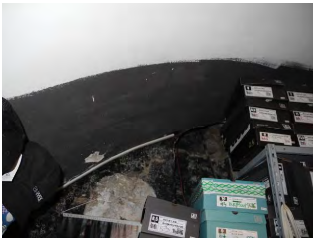
5. Boltă tencuită și pereți din piatră la subsol
