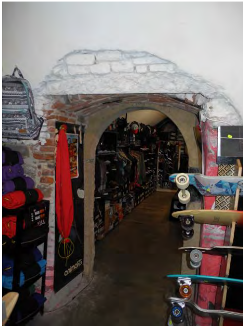
3. Ancadrament din piatră la subsol
