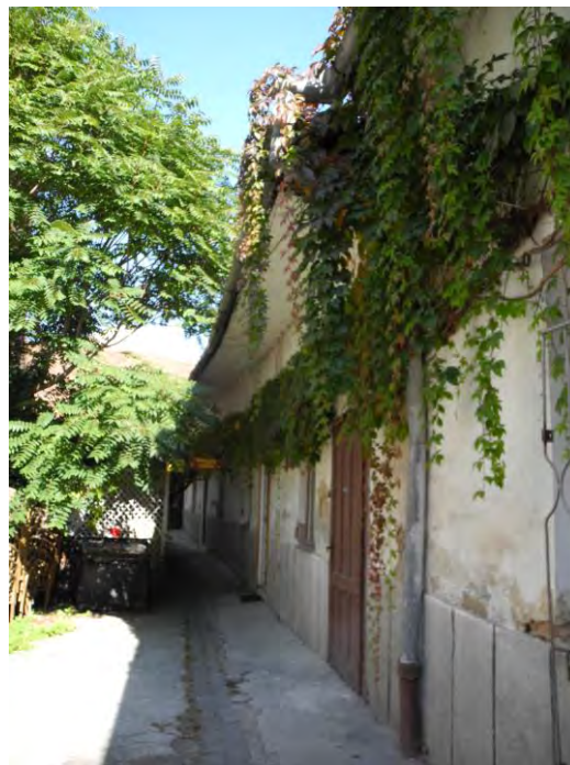
14. Fațada de vest
