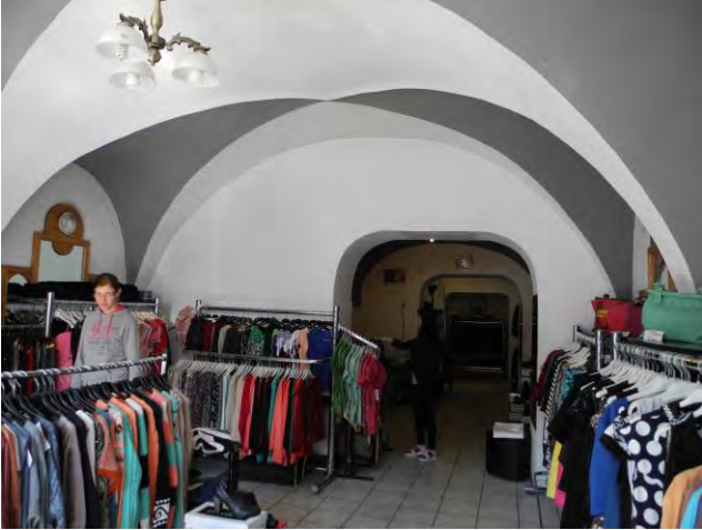
23. Încăperea P01 – boltă semicilindrică cu penetrații
