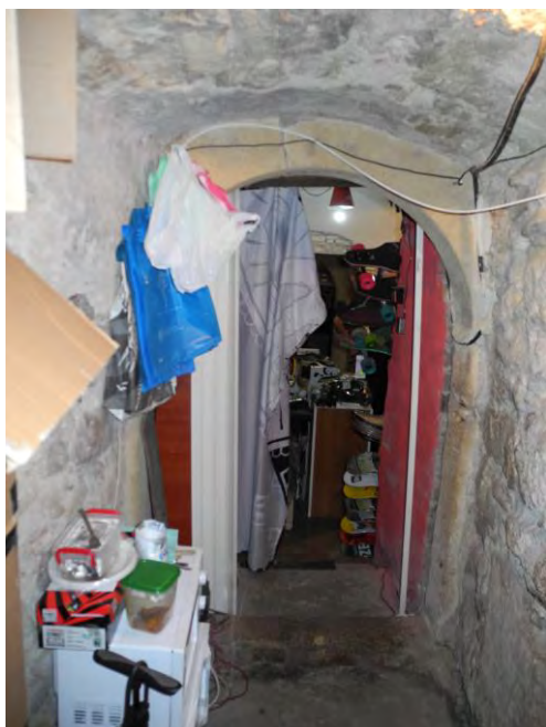
21-22. Subsolul boltit semicilindric și cele două ancadramente din piatră
