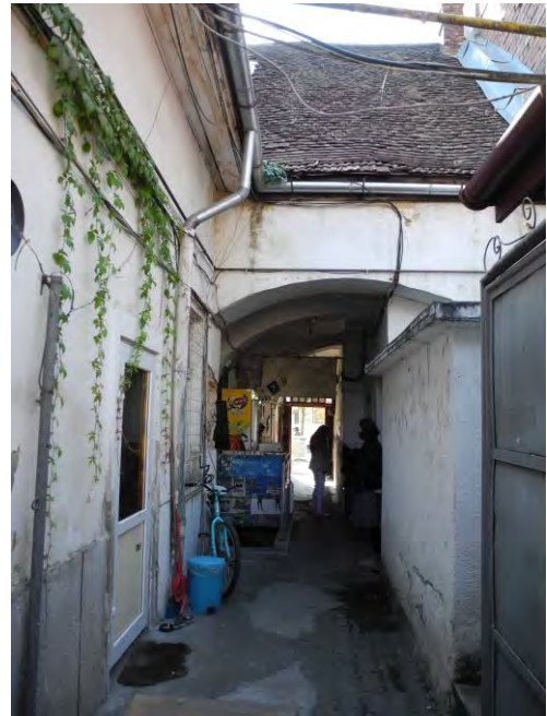
12. Construcții parazitare în gang și în curte
