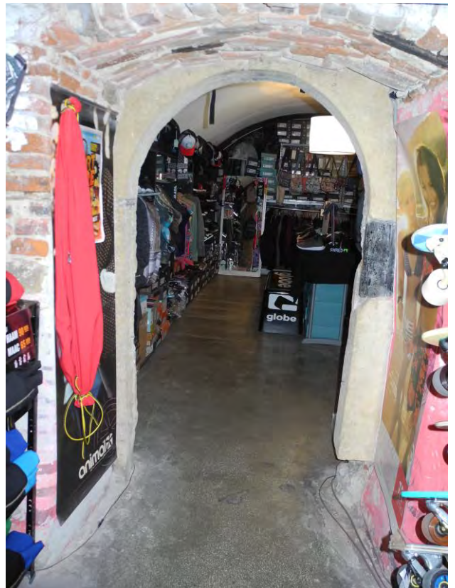
9-10. Ancadramente de piatră la subsol și ambrazură completată cu cărămidă
