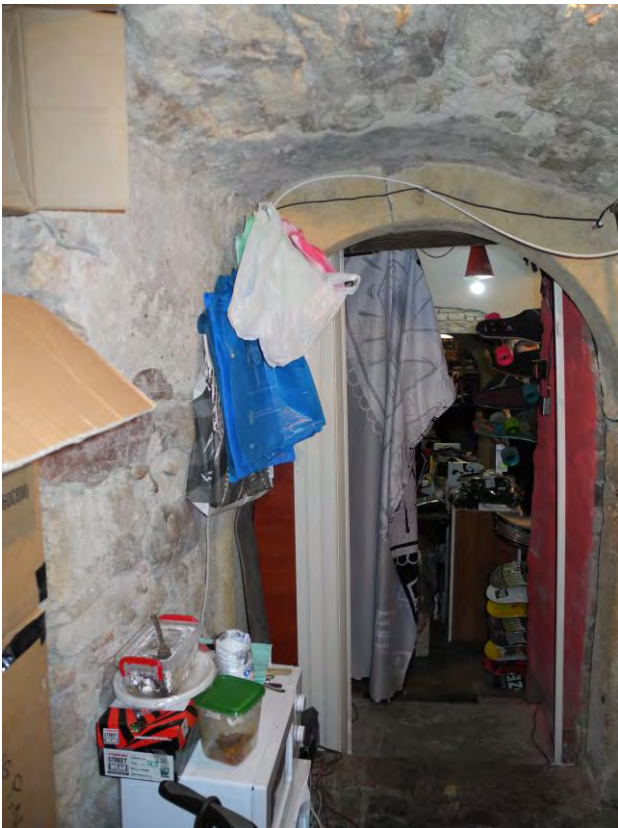
9-10. Ancadramente de piatră la subsol și ambrazură completată cu cărămidă
