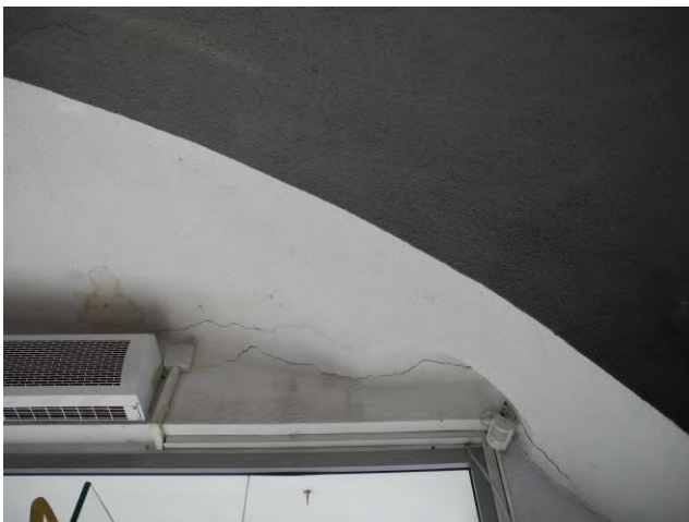
15. Bolți retezate în încăperea P01
