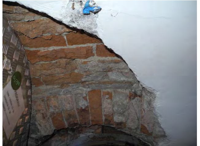
2. Zidărie din cărămidă la subsol în S01
