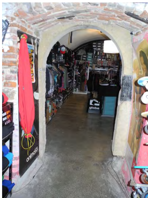
21-22. Subsolul boltit semicilindric și cele două ancadramente din piatră
