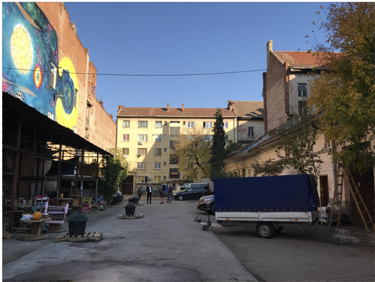
FOTO CURTE-VEDERE SPRE STRADA HOREA (EST)
