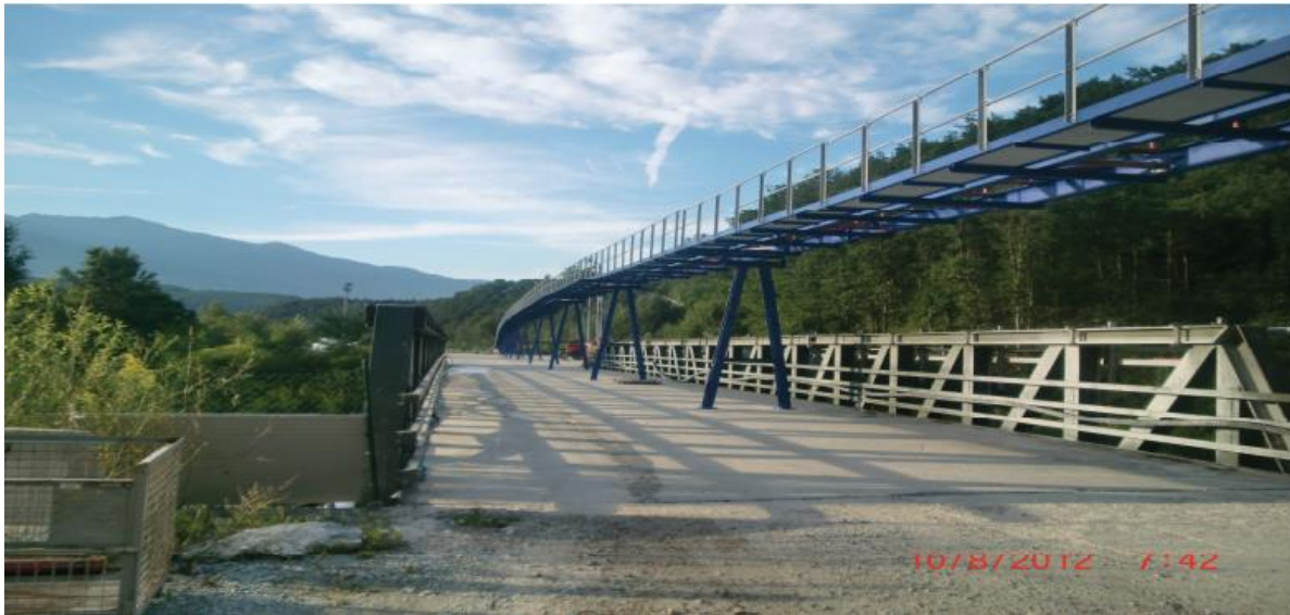
Figura 10-7.: Transportor cu bandă pentru material excavat în afara tunelului
