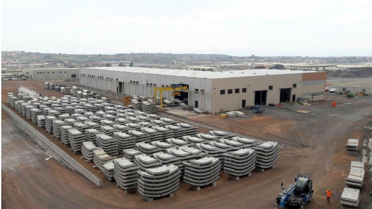
Figura 10-4.: Zona de depozitare a segmentelor prefabricate de inel.
