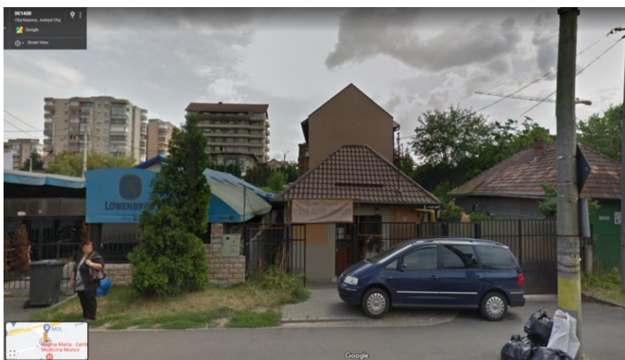
Figura 4-14. Amplasament și vedere imobil situat pe Str. Teodor Mihali nr. 11
