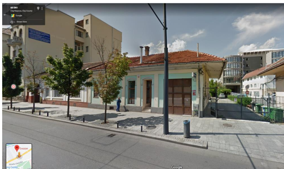
Figura 4-2. Amplasament și vedere imobil situat pe Calea Moților nr. 64
