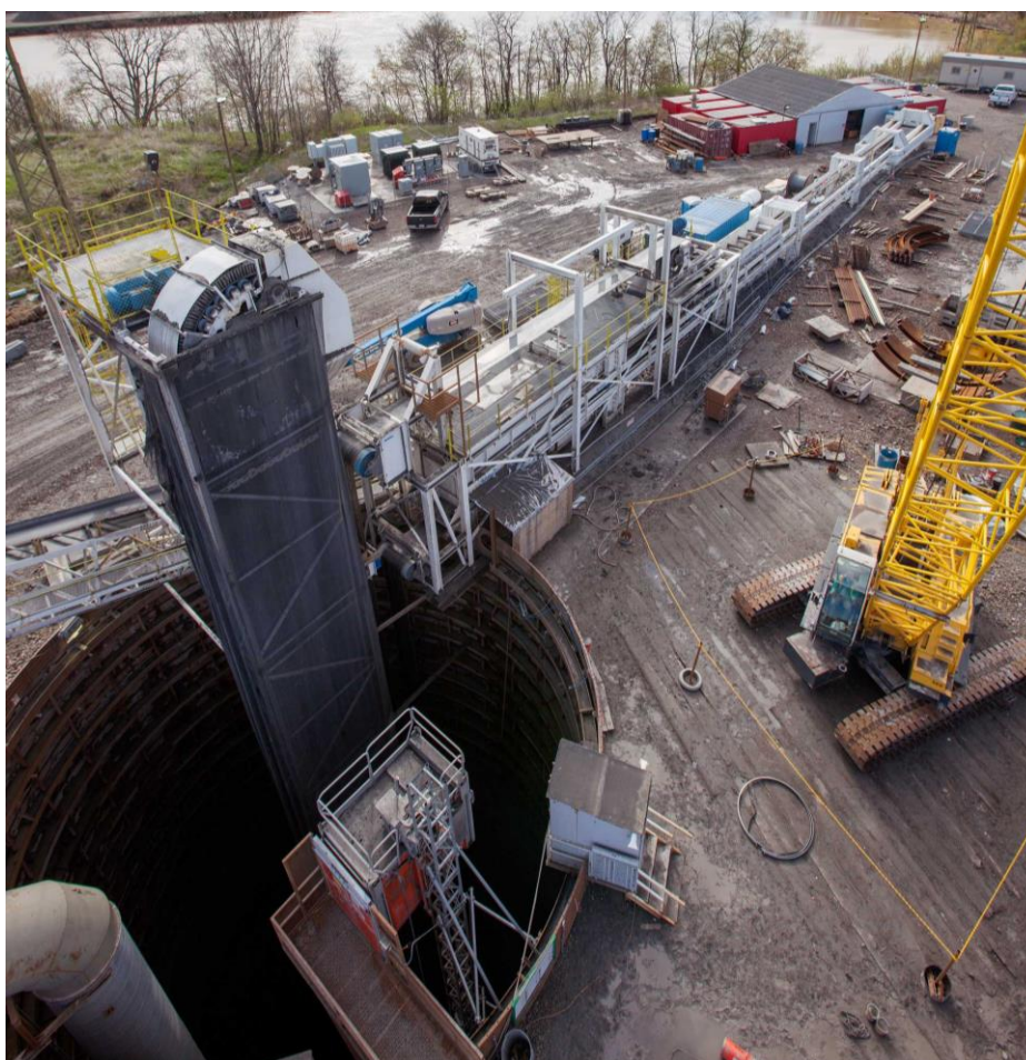
Figura 10-9.: Transportor cu bandă verticală pentru materialul excavat dintr-un put vertical
