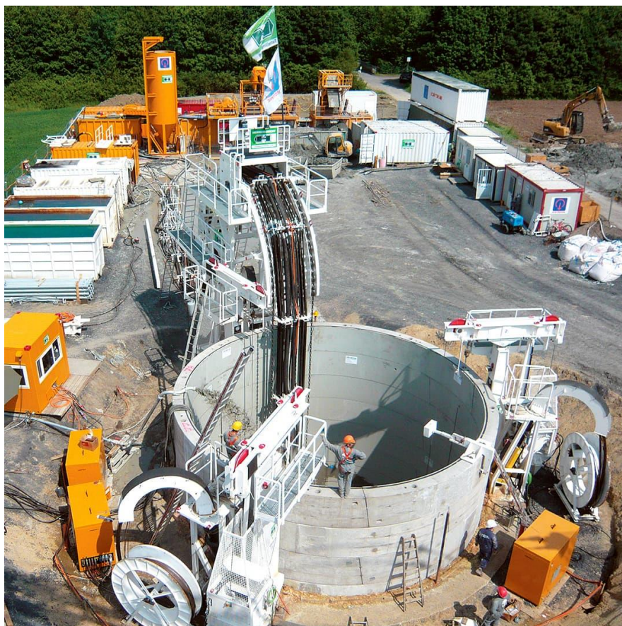
Figura 3-19. Santier tipic pentru VSM
