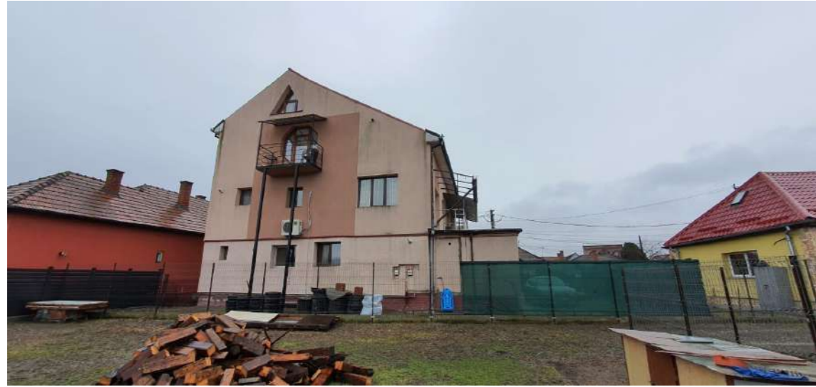
Vedere latura sudica
