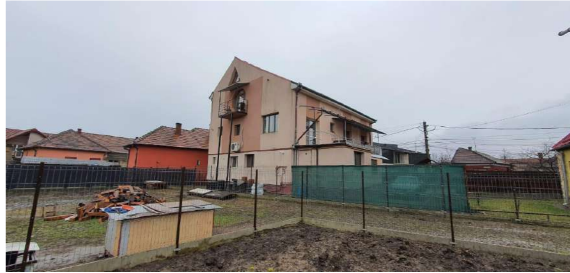
Vedere latura sudica
