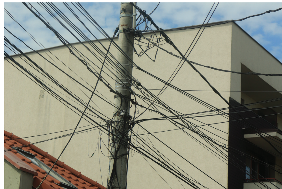
imaginea zonei este marcată de cabluri dispuse pe stâlpi
