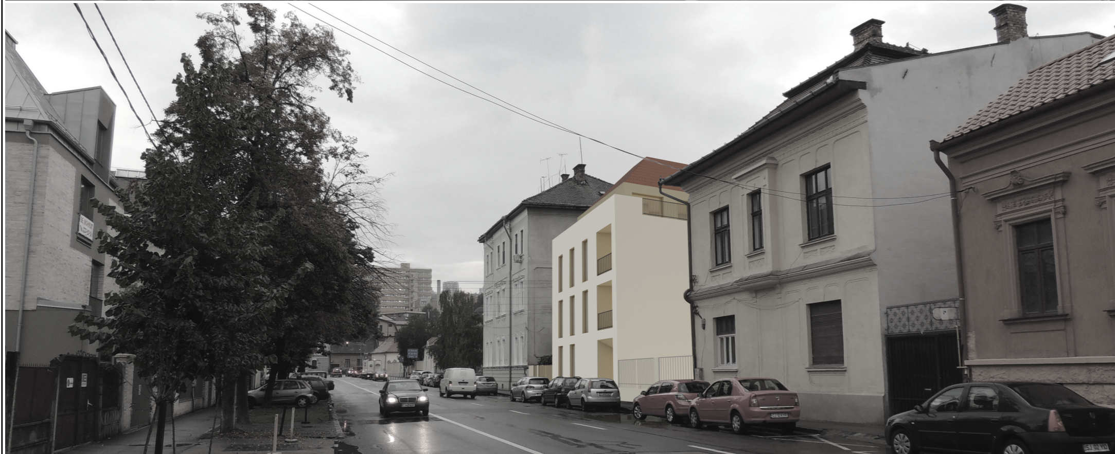
Vedere dinspre nord Str.George Coșbuc
