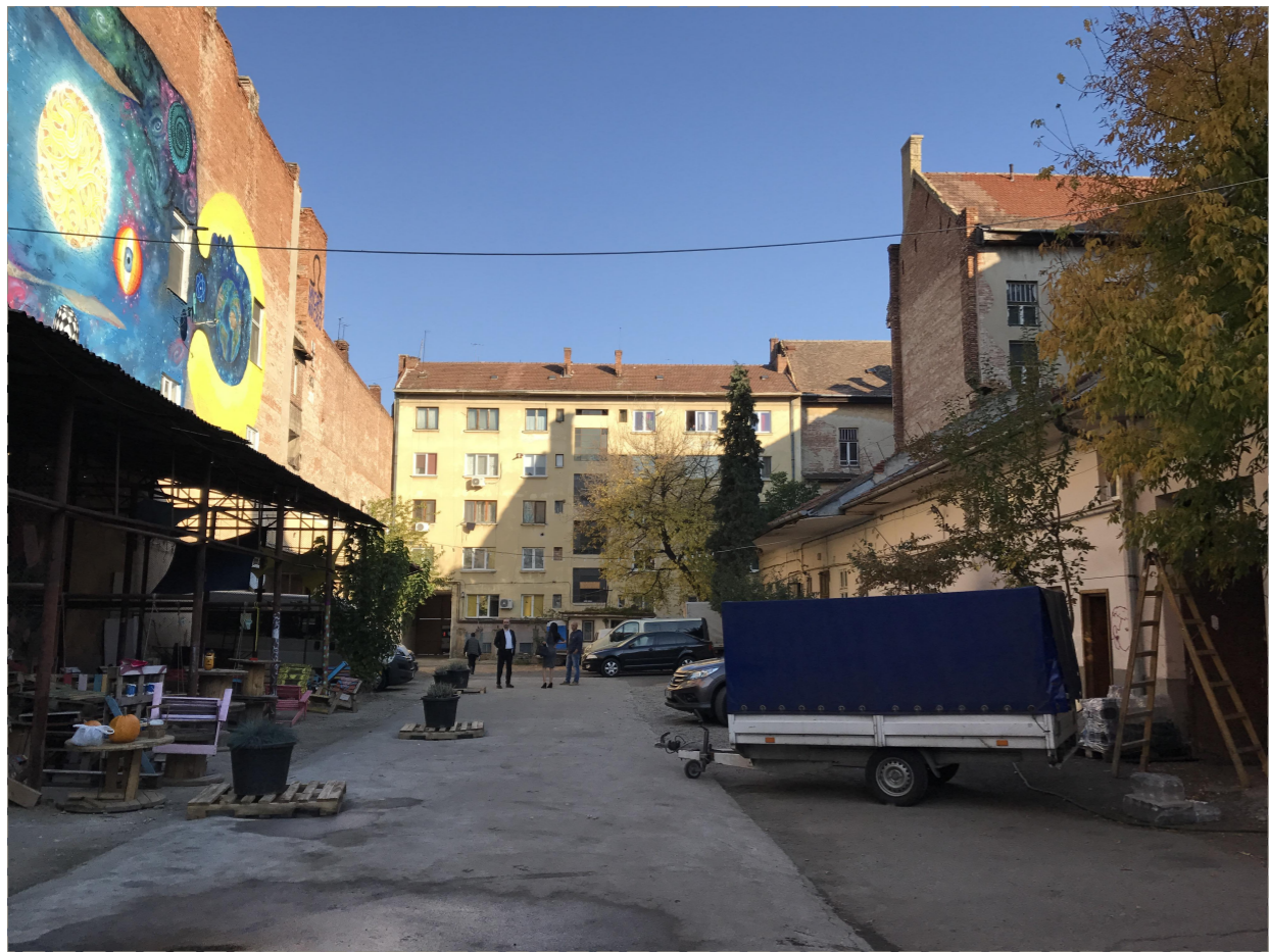
FOTO CURTE-VEDERE SPRE STRADA HOREA (EST)
