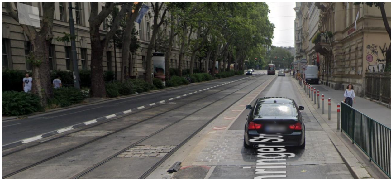
FIGURA 157 AMENAJARE STAȚIE DE TRAMVAI DE TIP "VIENA" - WÄHRINGER STR. VIENA
