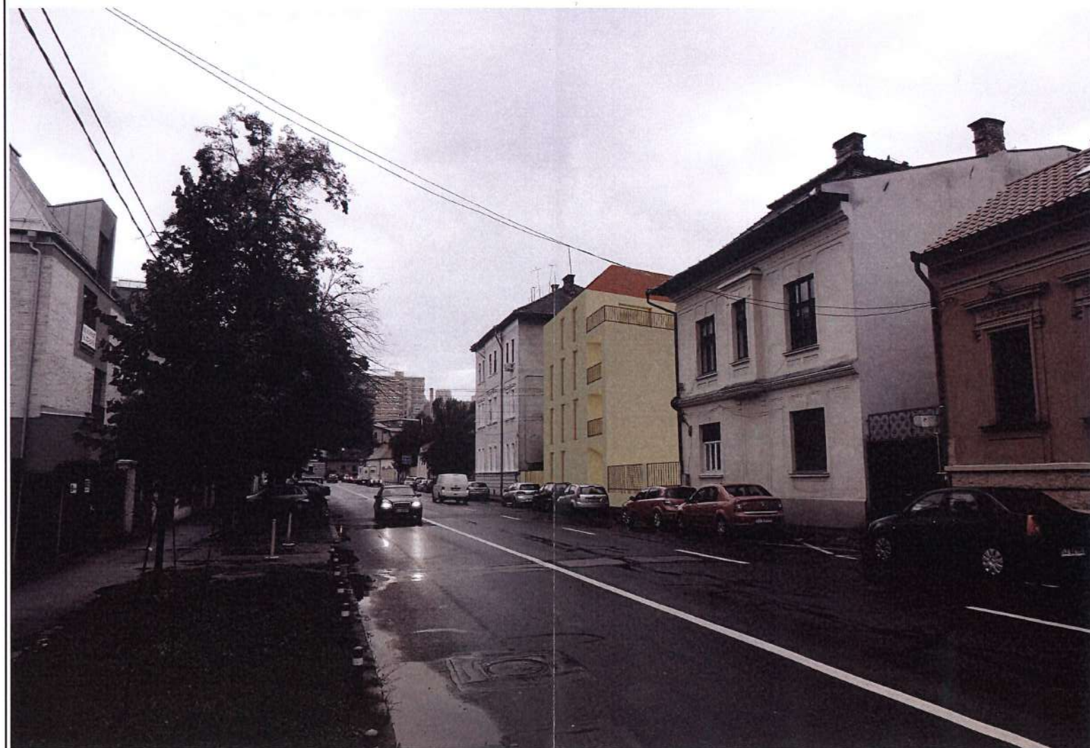
Vedere dinspre nord Str.George Coșbuc
