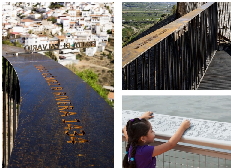
Figura 20 – Parapeți ornamentali și cu rol signalistic
