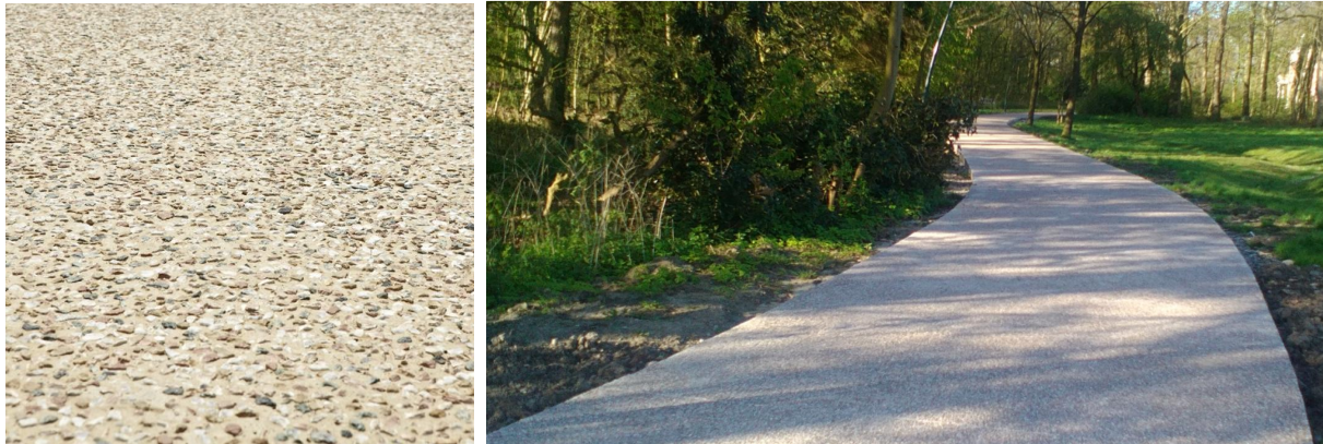
Figura 16 – Suprafață de călcare din beton dezactivat (agregate expuse)
