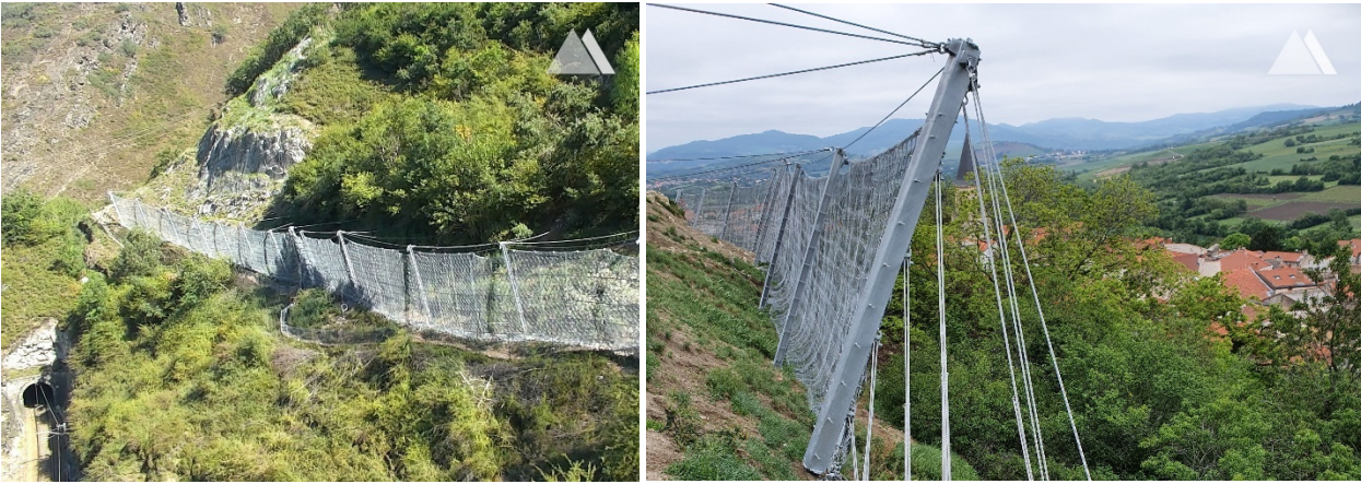
Figura 12 – Bariere de protecție, împotriva căderilor de pietre, utilizate cu caracter temporar
