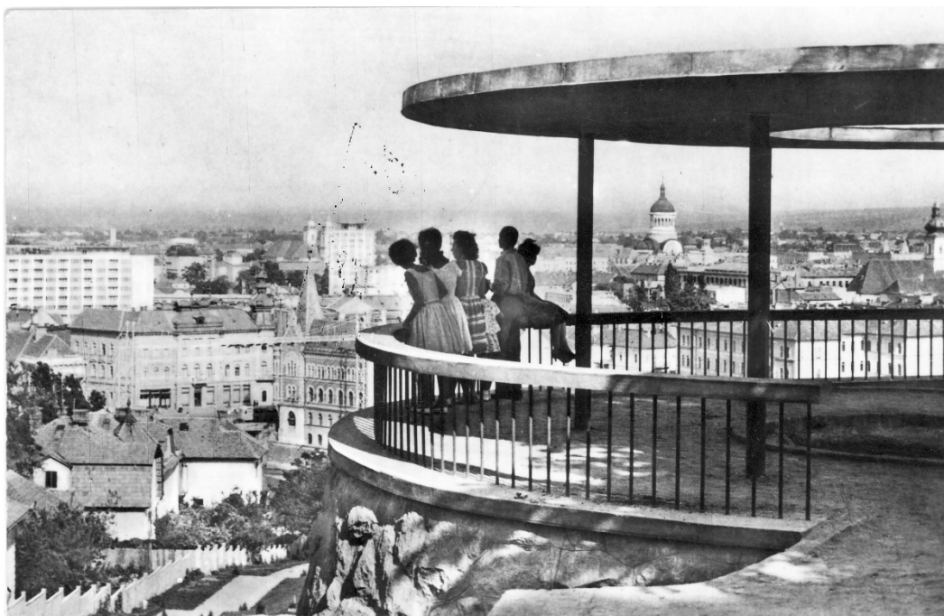
Figura 22 – Restaurarea pavilionului rotonda
