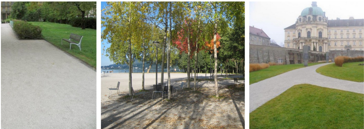
Figura 17 – Suprafață de călcare din agregate naturale stabilizate
