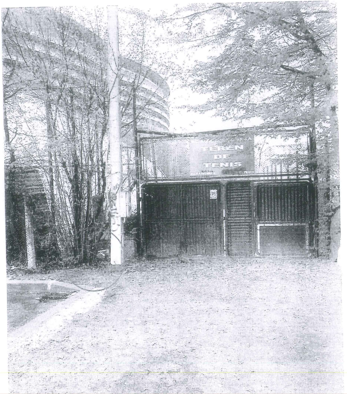
Poz. 4. Poartă acces auto și pietonal. Contor energie electrică.
