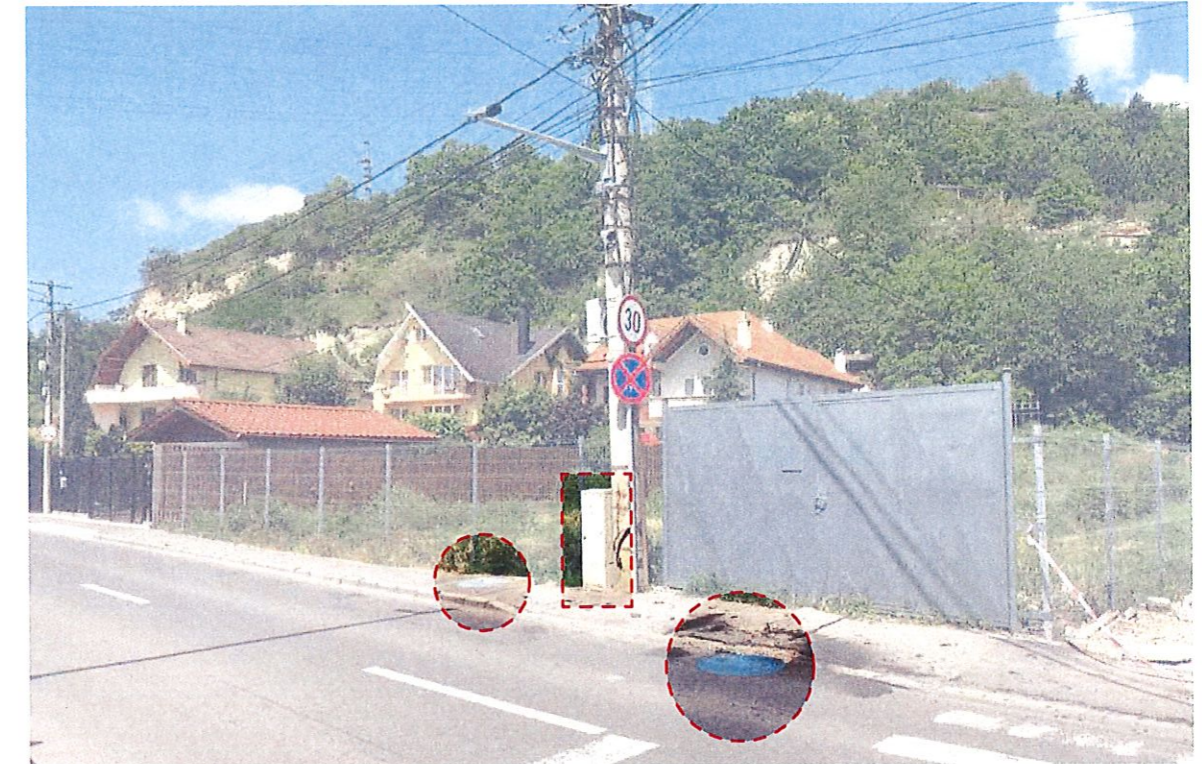
Fotografie 1 din 16.06.2021 - bransament existent - curent electric si pozitie canale apa existente
