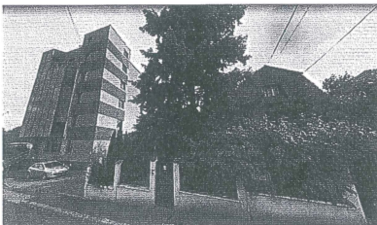
STRADA AVIATOR BADESCU, CLADIRE PE COLT D+P+4, LANGA CASA PARTER
