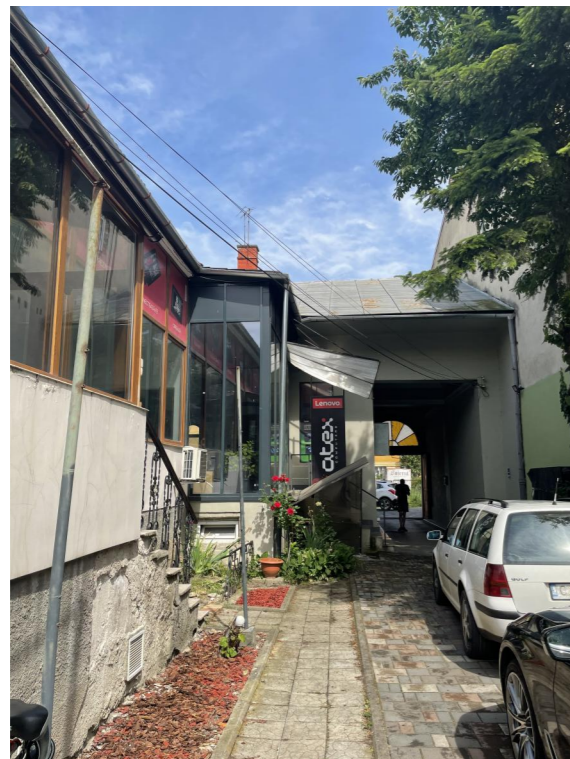
POZE FAȚADE CURTE - SITUAȚIA EXISTENTĂ
