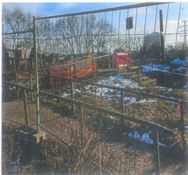
Poza 8 Rampe de acces degradate: denivelari si degradari ale caii
