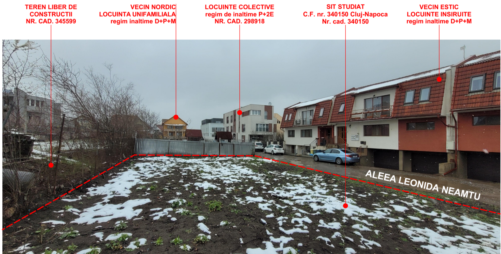
F2 - VEDERE SPRE LATURA NORDICA
