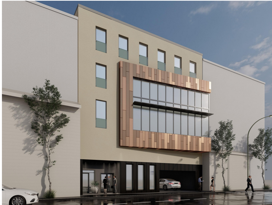
Fatada principala tencuiala decorativa bej deschis si placaj metalic fatada ventilata
