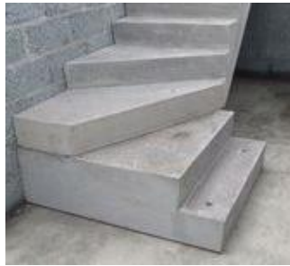
Figură 5-17 Trepte beton prefabricate gri deschis
