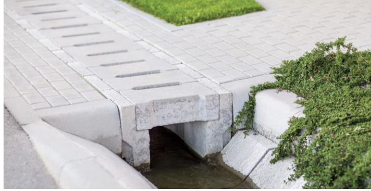
Figură 5-8 Rigolă din beton prefabricate
