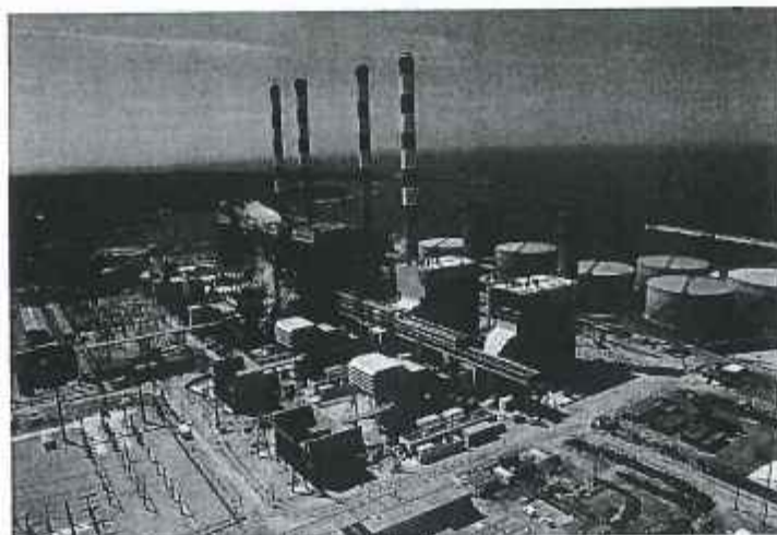
Instalație care funcționează după ciclul combinat bazat pe turbine cu gaze https://www.edf.fr/sites/default/files/contrib/groupe-edf/producteur-industriel/thermique/atouts/technologies-avancees/centrales-a-cycle-combine-au-gaz/ccg_martigues_1.jpg
