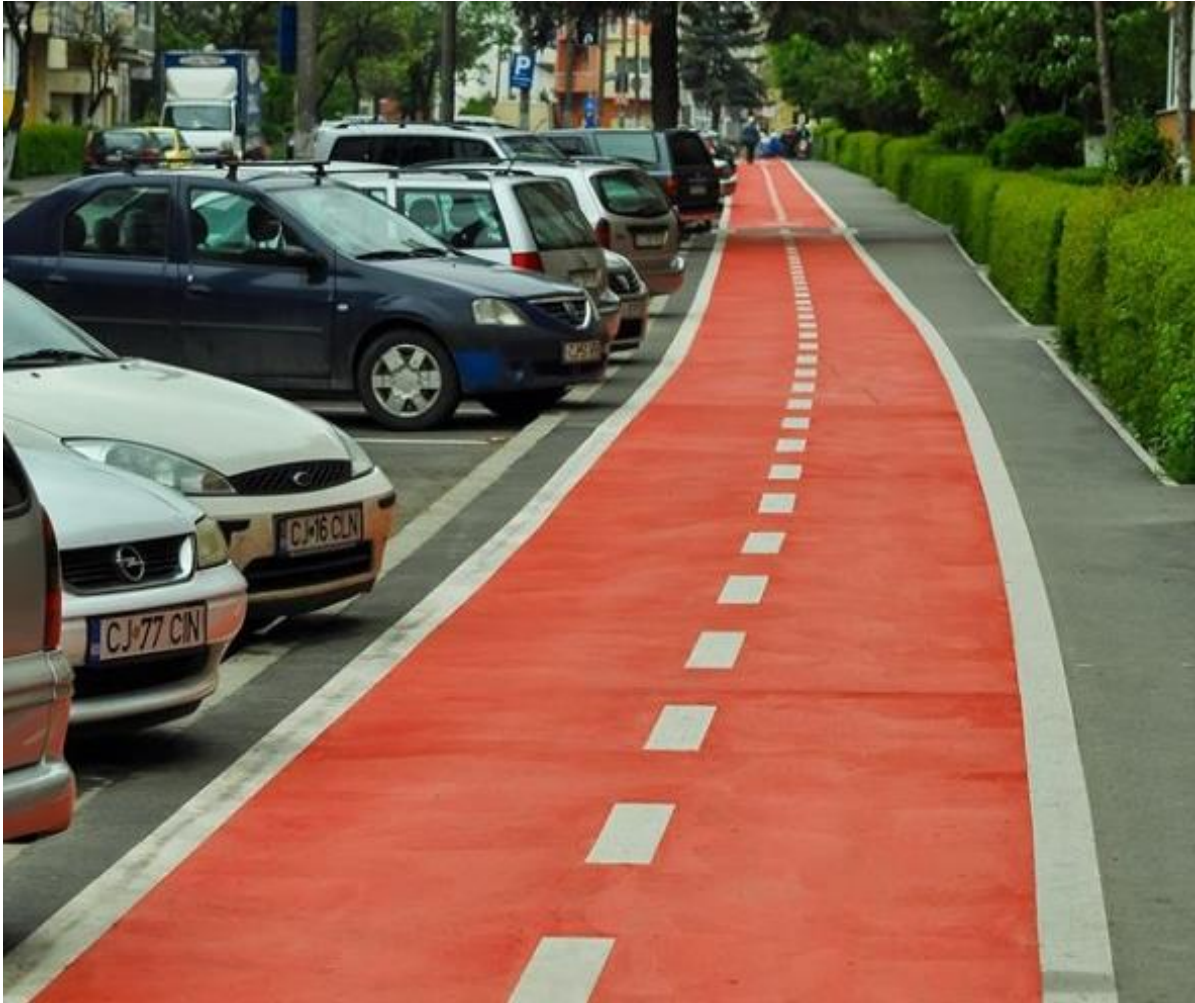
Figura 23 - Exemplu de mod inadecvat de realizare a pistelor pentru biciclete în Cluj-Napoca (str. Donath)
