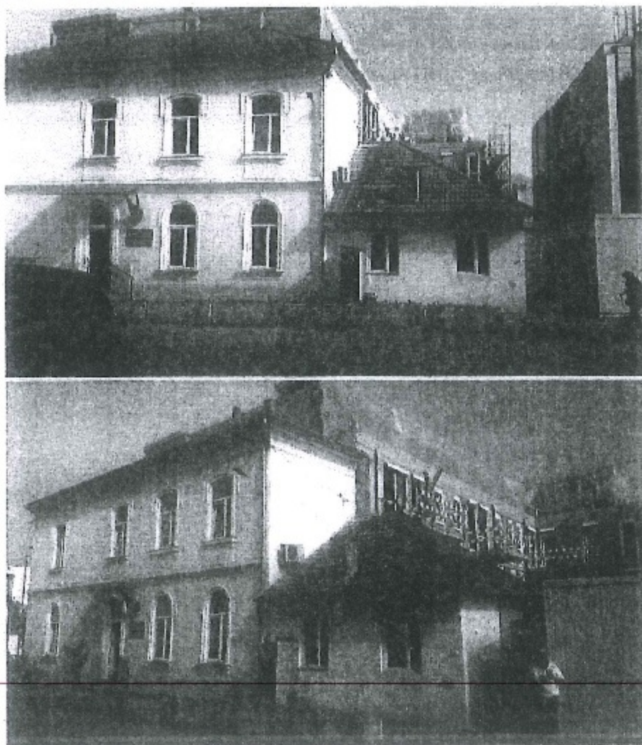
Foto 1 - Fațada principală Imobil
