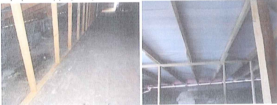
Figura 10. Imagini foto a acoperișului clădirii vederea din interior
