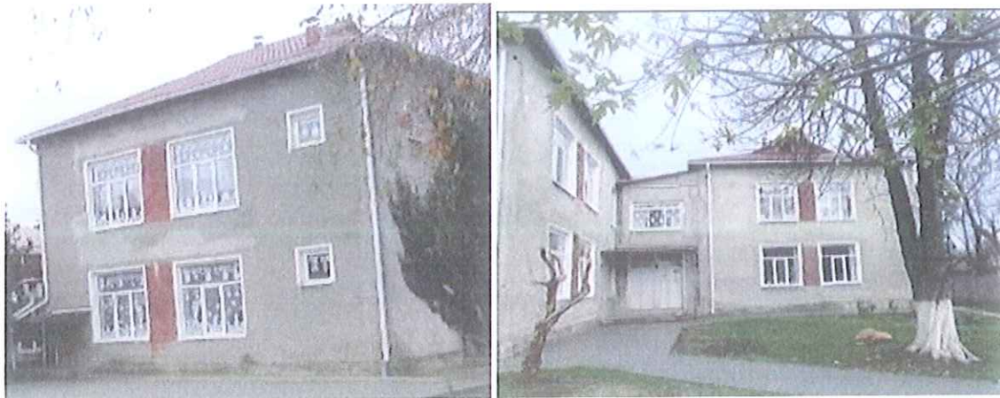
Figura 5. Structura perete exterior până la renovare
