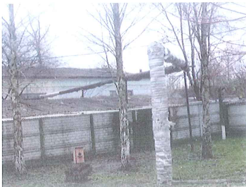
Figura 25. Conducta de alimentare cu energie termică de la furnizor
